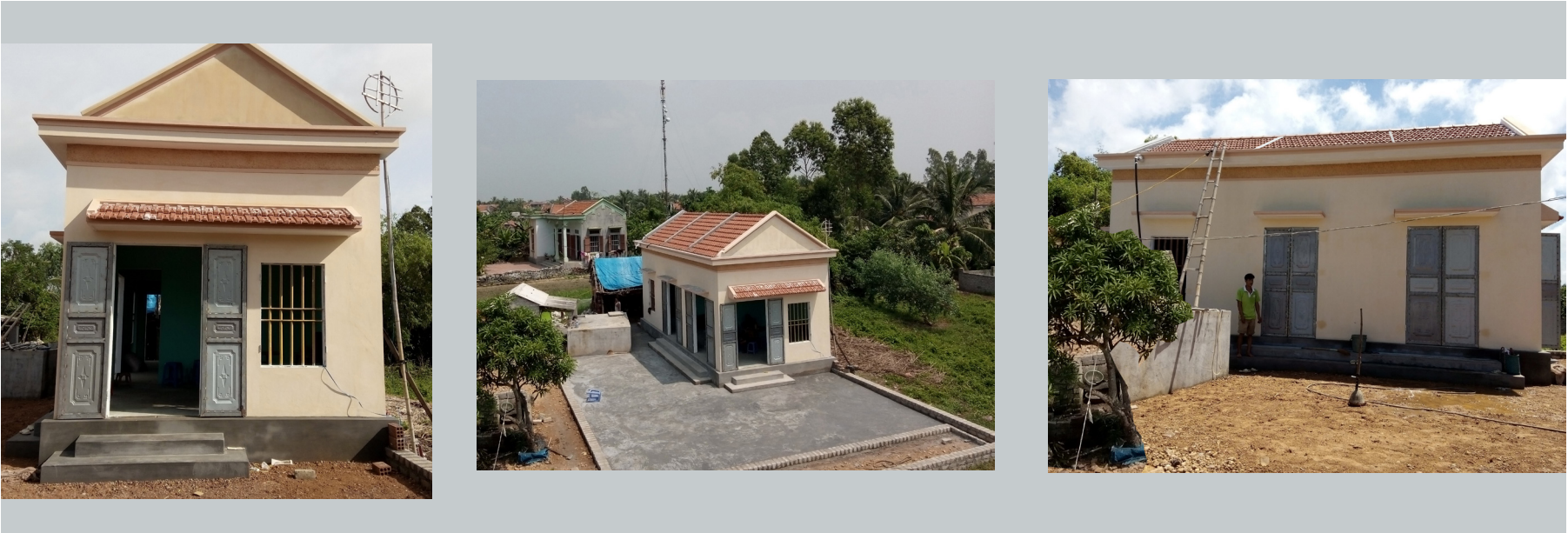
Hình ảnh mô hình nhà phòng tránh thiên tai được xây dựng trên địa bàn tỉnh Quảng Ninh Nhà ông Nguyễn Văn Hiện, Xã Tiền Phong, Thị Xã Quảng Yên, Tỉnh Quảng Ninh
