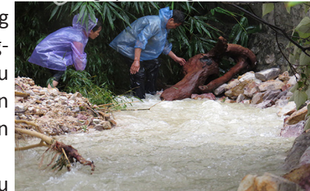
Kê đá kê bờ chống sạt lở
