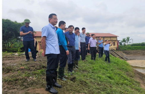
Thủ trưởng Nguyễn Hoàng Hiệp cùng đoàn công tác kiểm tra sự cố mạch đùn, mạch sủi tại trạm bơm Cẩm Bào và sạt lở bờ, bãi sông đoạn K8+100-K8+500, đề tả Cầu – Bắc Ninh
