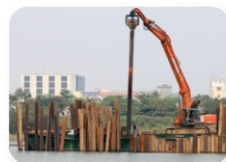
Xây dựng đập tạm ngăn mặn khi cần
