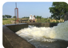
Khi nước sông đảm bảo lưu lượng, cần mở các âu cống dẫn nước ngọt vào để đẩy mặn
