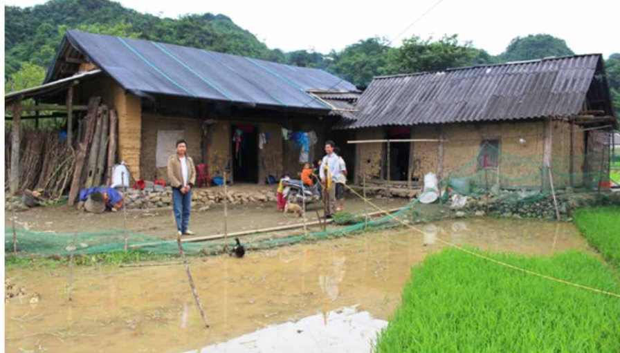
Căn nhà trình tường thực hiện mô hình điểm “chằng néo mái nhà phủ lưới” chống mưa bão của hộ bà Ly Thị Dế, thôn Nậm Lương, xã Quyết Tiến
