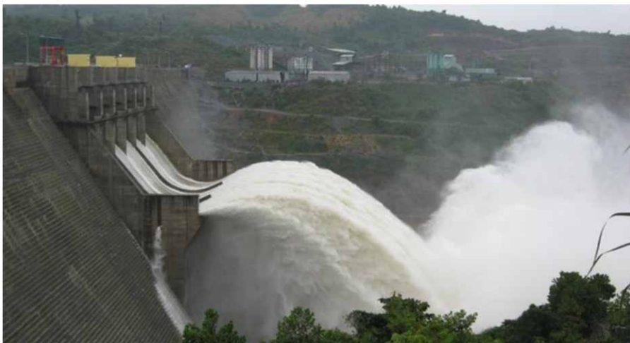
Hồ thủy điện Hòa Bình mở 8/12 cửa xả đáy trong đợt mưa lũ tháng 10/2017
