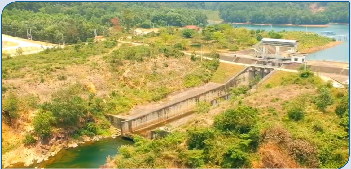
(Hình ảnh đập phụ tại Hồ Phú Ninh)
