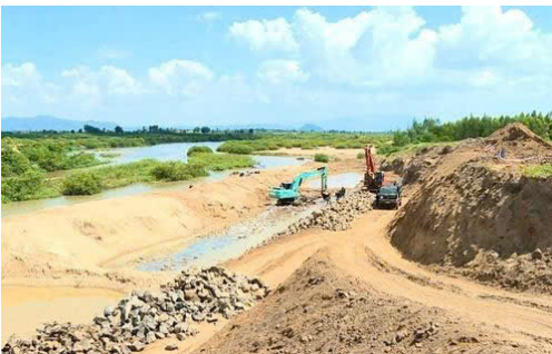
Gia Lai khởi công dự án bờ kè chống sạt lở sông Ba.
