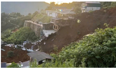
Toàn cảnh vụ sạt lở sạt lở tại tại bản Tà Xùa, xã Tà Xùa, huyện Bắc Yên, Sơn La ngày 10/8/2024
