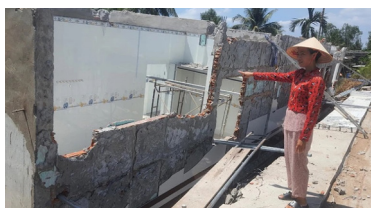
Tình trạng sạt lở đất, sạt lở nhà dân xuống sông và kênh mương
