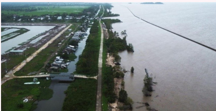
Hiện trạng sạt lở bờ biển Tây trên địa bàn tỉnh Cà Mau
