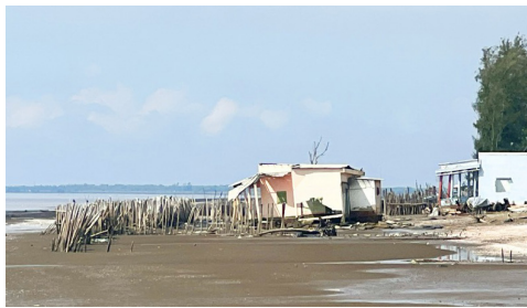
Hiện trường sạt lở, xâm thực bờ biển huyện Ba Tri
