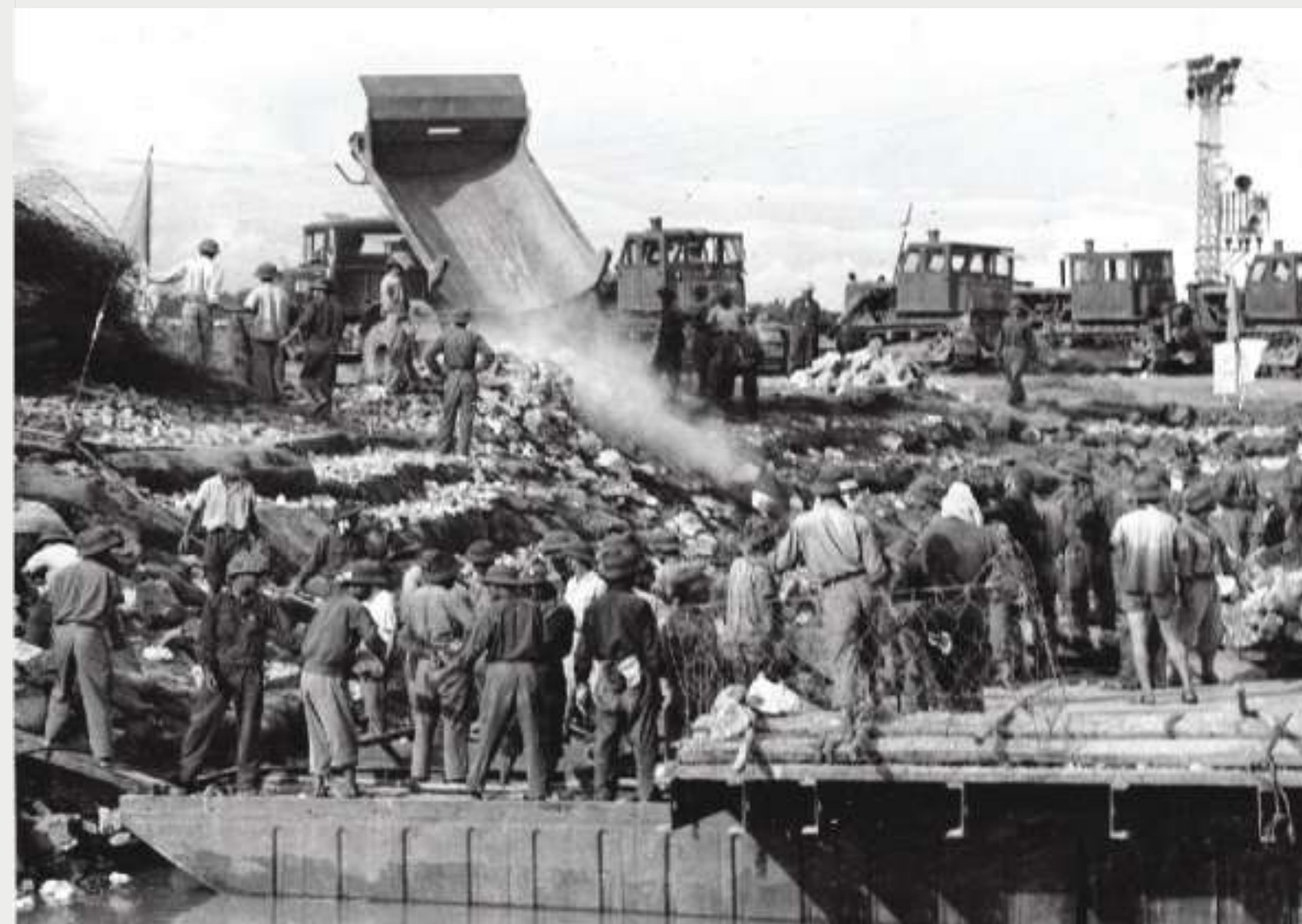
Đội vận tải X đang chuyên chở xuống phá đưa ra mố A tại công trường T100 hàn khẩu đê Bắc Dương, năm 1971
