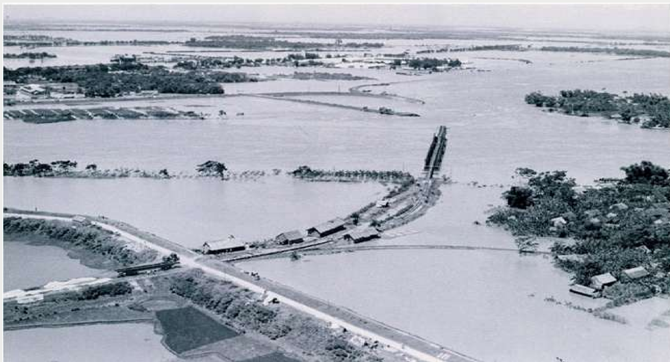
Sự cố vỡ cống Thôn, thuộc khu vực Cầu Đường, ngày 23/08/1971
