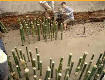
Gia cố nền bằng cọc tre
