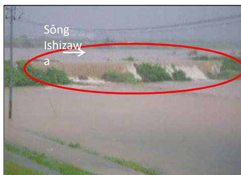
Ví dụ: Sông Koyoshi trong hệ thống sông Ishizawa Đê vỡ do nước tràn (trận lụt 6/2011)
