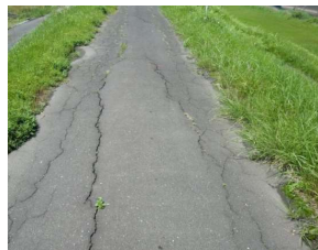
Sửa chữa rạn nứt thân kè
