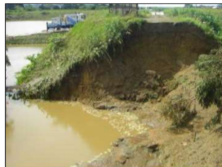
Ví dụ: Sông Koyoshi trong hệ thống sông Ishizawa Đê vỡ do nước tràn (trận lụt 6/2011)
