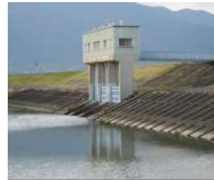
Ống dẫn nước
