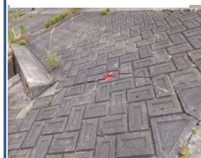
Sửa chữa rạn nứt thân đê
