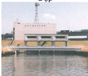
Trạm bơm tiêu
