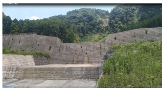
Đập kín, Tiêu năng và kè hạ lưu rất quan trọng
