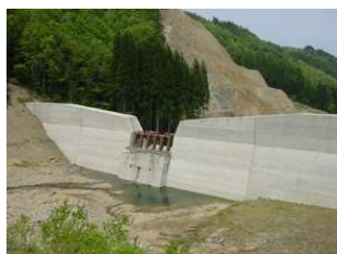
Loại đập sabo hở một phần
