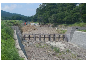
Đập kết hợp bể tích trữ bùn đá
